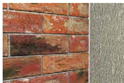
Juntas entre distintos muros
