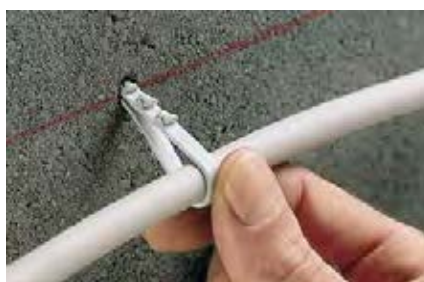
Fijación de cables
