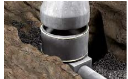
Sellado de tapas de aguas servidas en hormigón
