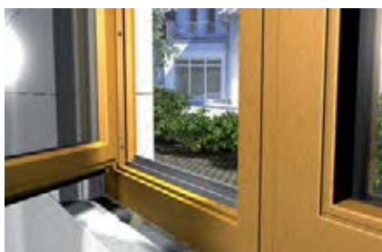
Fijación de marcos de aberturas
