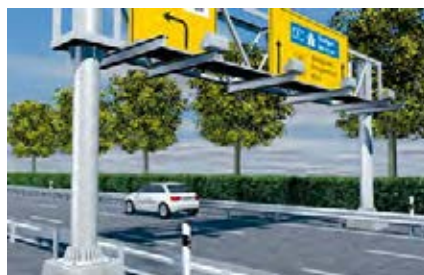
Estructuras para señales viales
